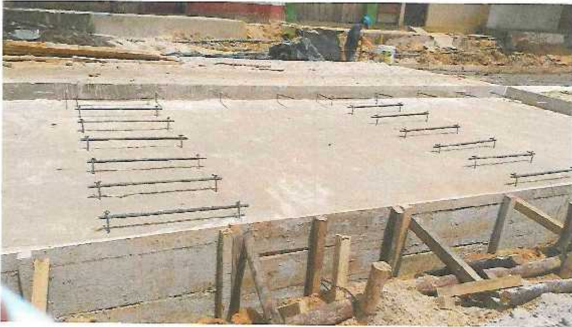
FOTOGRAFÍA 12: COLOCACIÓN DE PASADORES DE FIERRO LISO Ø 5/8" (Dilatación) EN LA CA. URARINAS.
