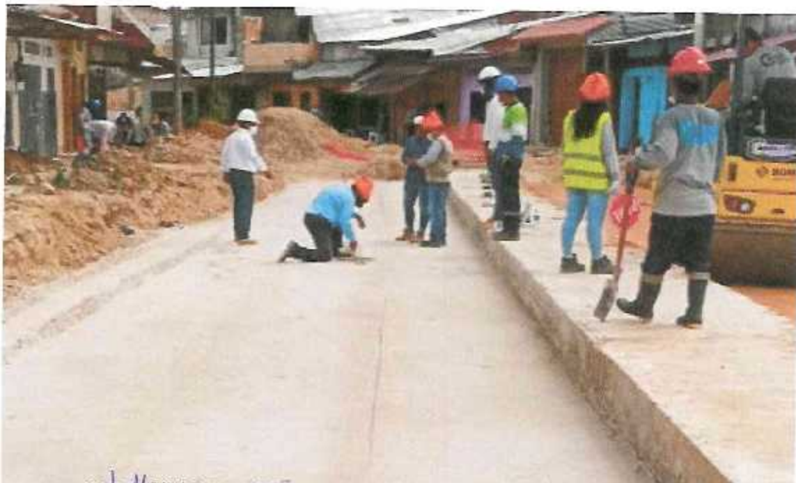
FOTOGRAFÍA 04: SE CONTINUA CON LA PRUEBA DE DENSIDAD DE CAMPO DE CAPA ANTICONTAMINANTE CON MATERIAL (A-3) A NIVEL DE SUB BASE EN LA CA. URARINAS.
