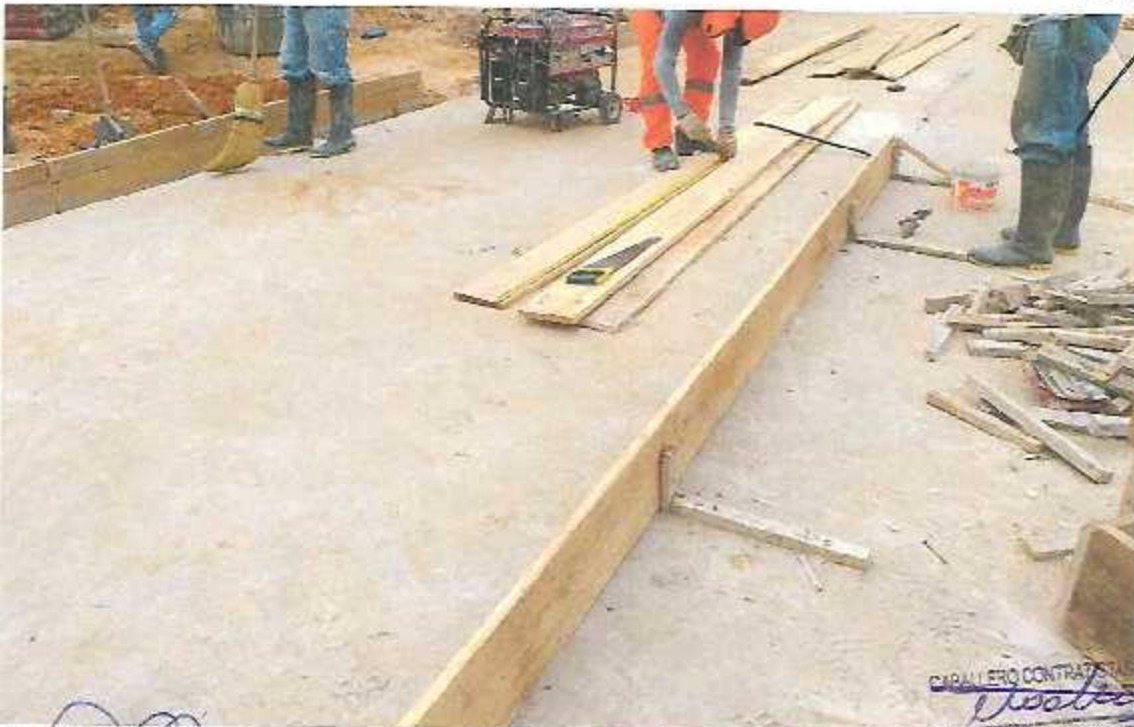
FOTOGRAFÍA 10: ENCOFRADO DE LOSA DE RODADURA EN LA CA. URARINAS.
