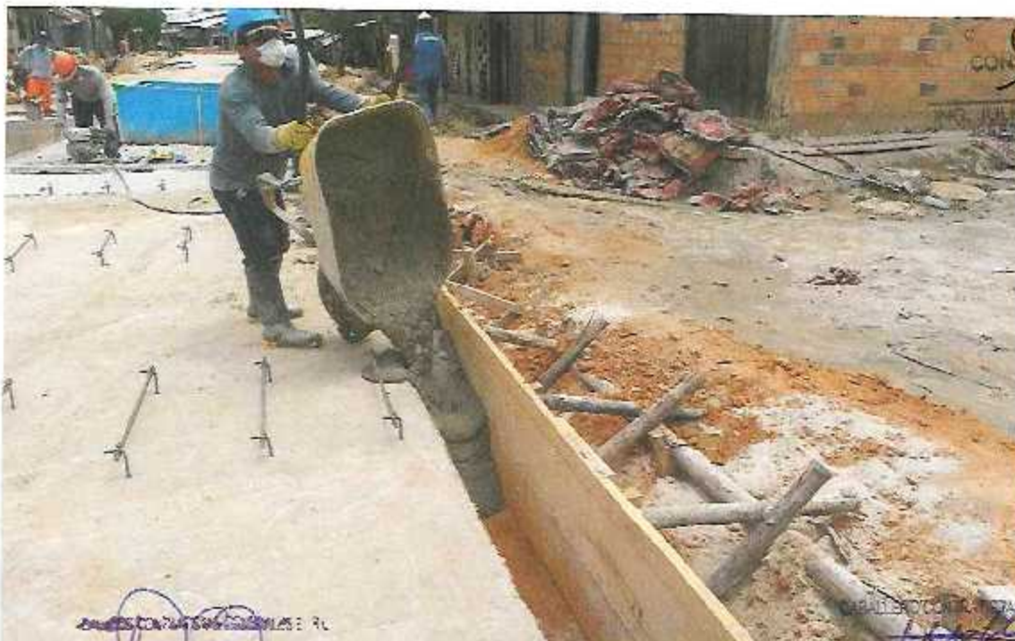
FOTOGRAFÍA 14: VACIADO DE MORTERO EN UÑAS PARA PAVIMENTO RÍGIDO MORTERO f_c=210 \text{ Kg/cm}^2 EN LA CA. URARINAS.
