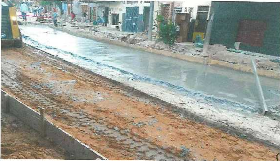
FOTOGRAFÍA 09: SE CONTINUA CON LOS TRABAJOS DE VACIADO DE SOLADO EN LA CA. URARINAS.
