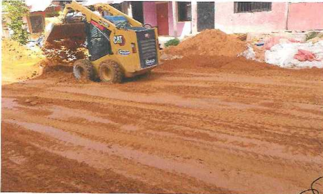
FOTOGRAFÍA 06: RELLENO Y COMPACTACIÓN DE BASE DEL MATERIAL DE PRESTAMO (A-2-4) EN LA CA. URARINAS.
