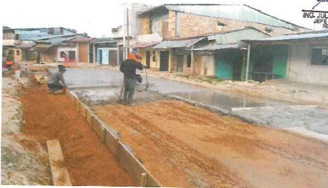
FOTOGRAFÍA 10: SE CONTINUA CON LOS TRABAJOS DE VACIADO DE SOLADO EN LA CA. URARINAS
