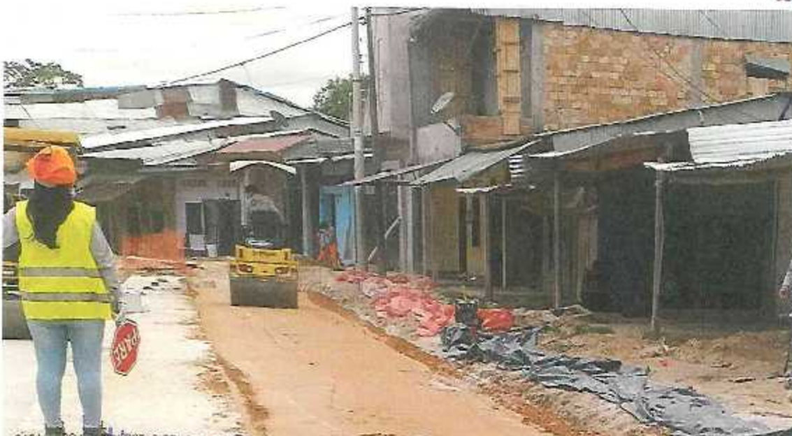
FOTOGRAFÍA 06: SE CONTINUA CON EL RELLENO Y COMPACTACIÓN DE BASE DEL MATERIAL DE PRESTAMO (A-2-4) EN LA CA. URARINAS.
