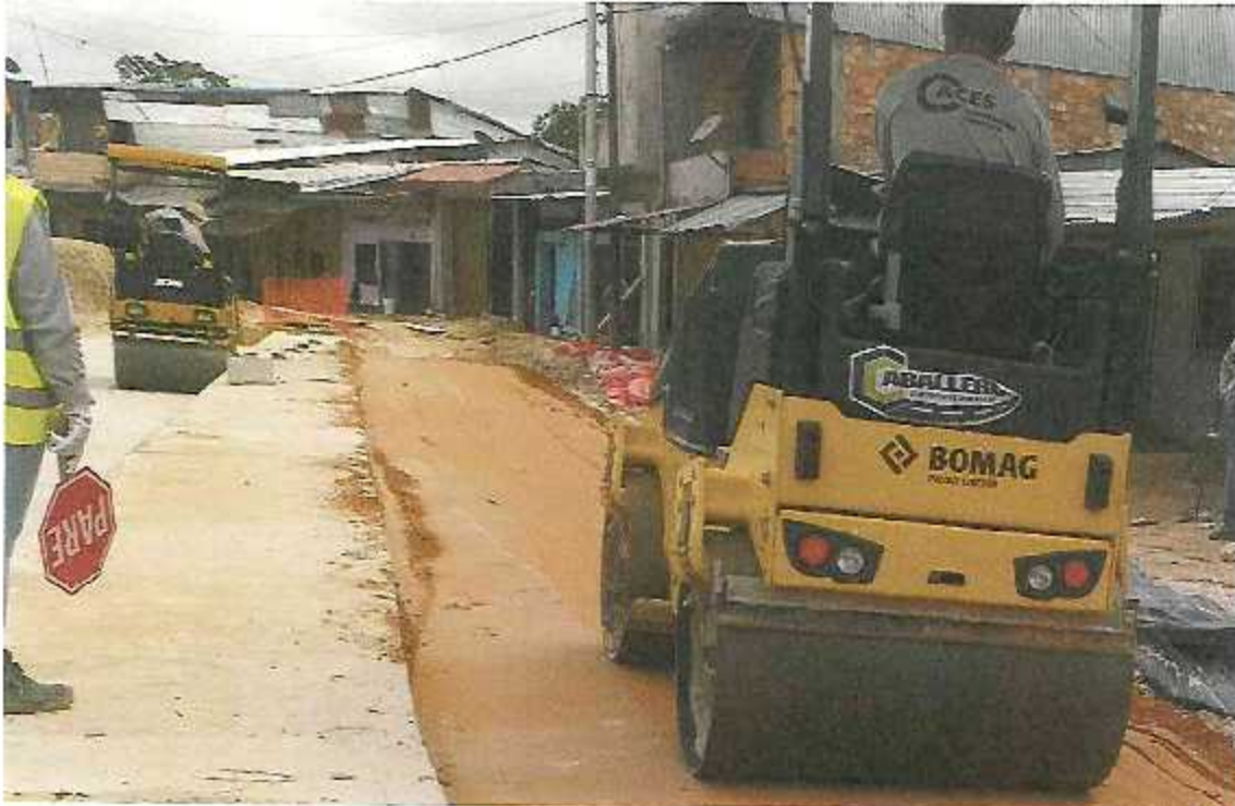
FOTOGRAFÍA 06: SE CONTINUA CON EL RELLENO Y COMPACTACIÓN DE BASE DEL MATERIAL DE PRESTAMO (A-2-4) EN LA CA. URARINAS.
