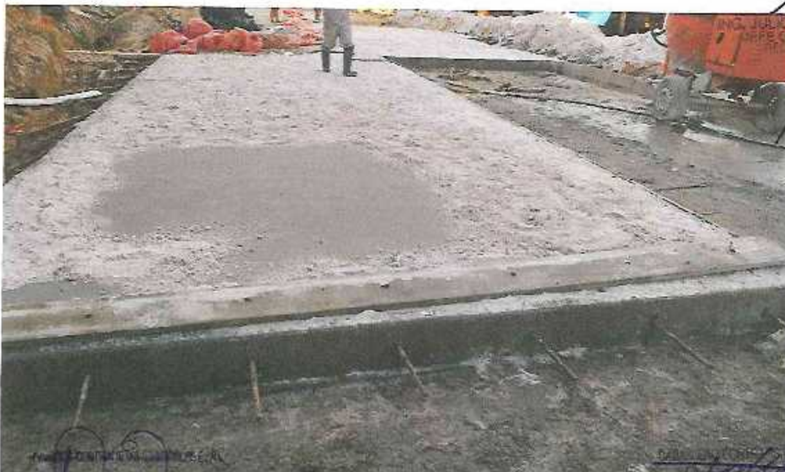
FOTOGRAFÍA 12: COLOCACIÓN DE PASADORES DE FIERRO LISO Ø 5/8" (Dilatación) EN LA CA. URARINAS.
