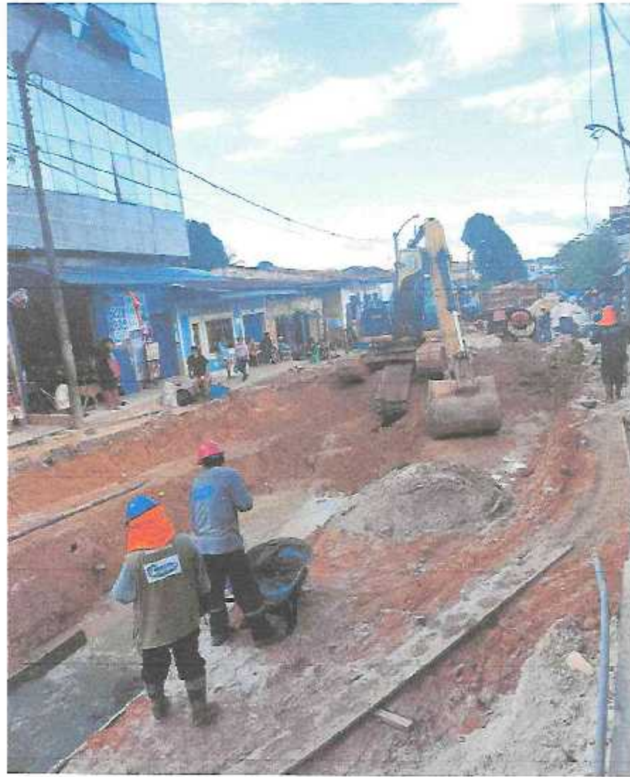
01.03.01.01 CORTE DE TERRENO A NIVEL DE SUBRASANTE CON MAQUINARIA
