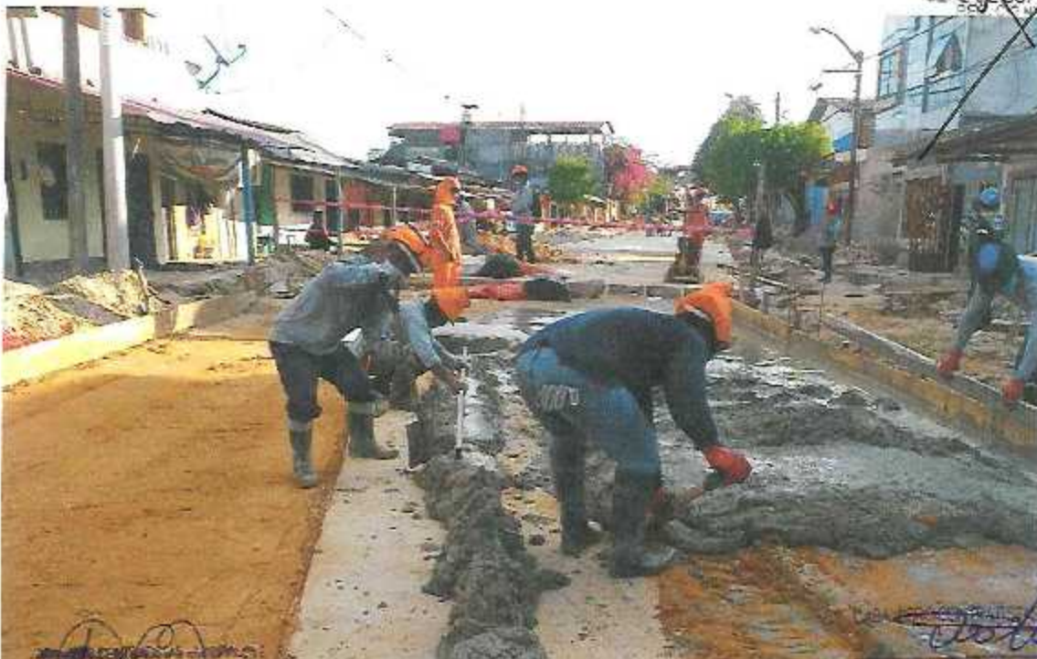
FOTOGRAFÍA 08: VACIADO DE SOLADO EN LA CA. URARINAS.
