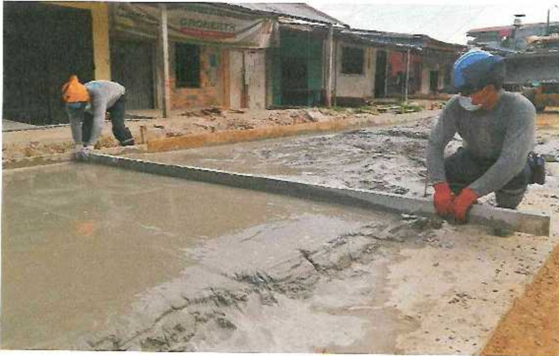
FOTOGRAFÍA 10: SE CONTINUA CON LOS TRABAJOS DE VACIADO DE SOLADO EN LA CA. URARINAS
