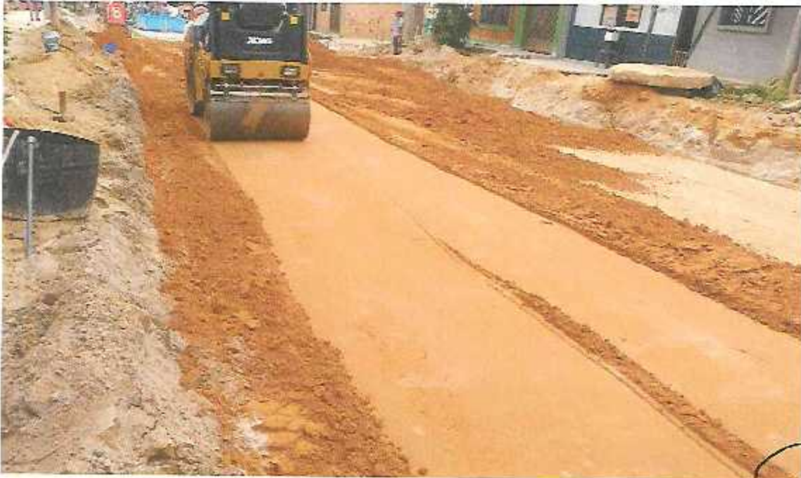
FOTOGRAFÍA 07: SE CONTINUA CON EL RELLENO Y COMPACTACIÓN DE BASE DEL MATERIAL DE PRESTAMO (A-2-4) EN LA CA. URARINAS.
