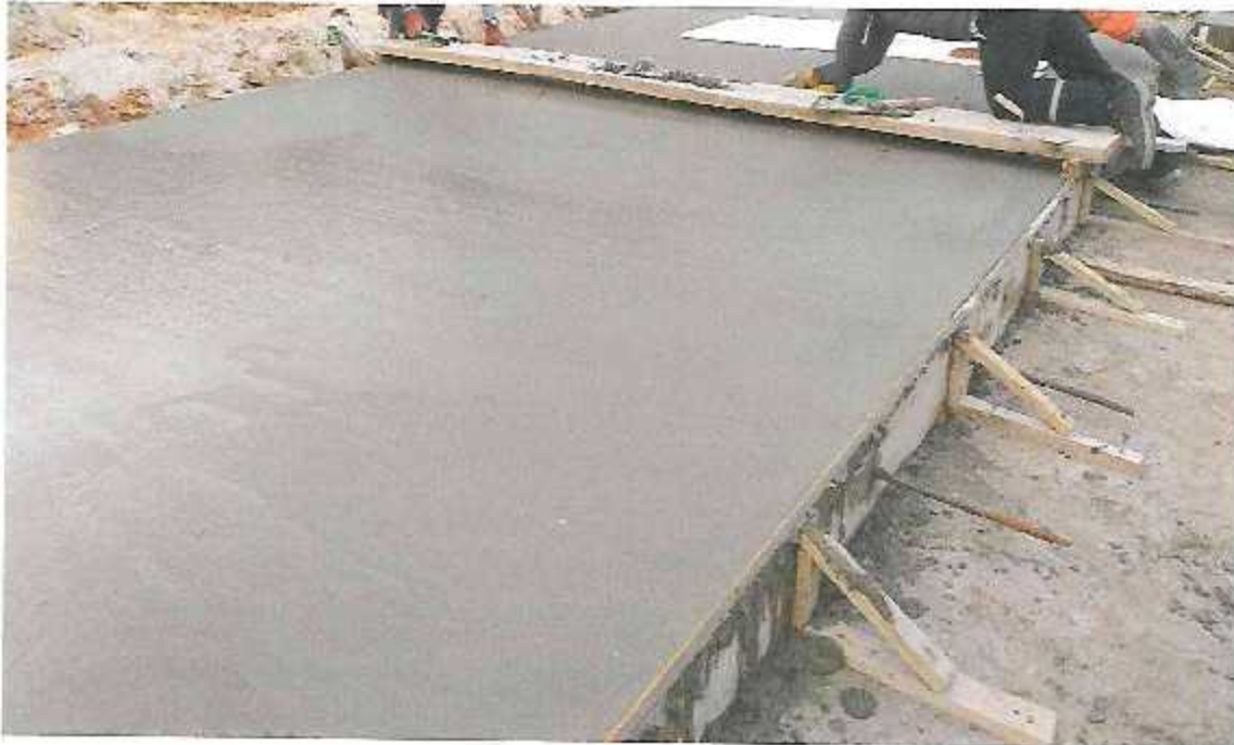
FOTOGRAFÍA 14: VACIADO DE MORTERO EN UÑAS PARA PAVIMENTO RÍGIDO MORTERO f_c=210 \text{ Kg/cm}^2 EN LA CA. URARINAS.
