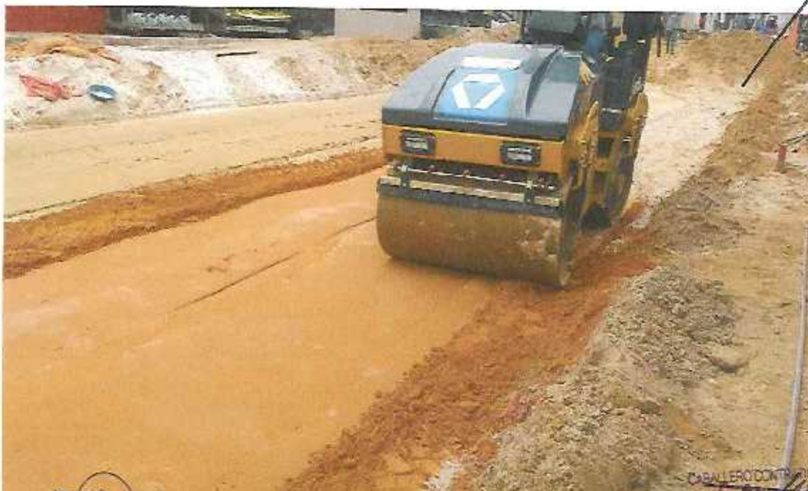
FOTOGRAFÍA 06: RELLENO Y COMPACTACIÓN DE BASE DEL MATERIAL DE PRESTAMO (A-2-4) EN LA CA. URARINAS.
