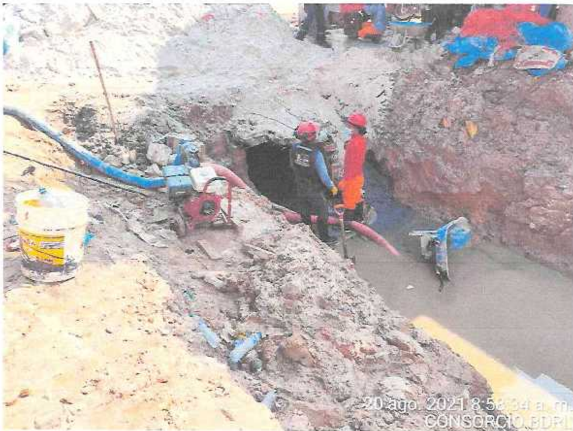
01.02.09 BOMBEO PARA ELIMINACIÓN DE AGUAS FILTRANTES Y PLUVIALES
